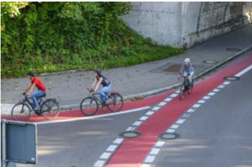
Beispiel für einen Radfahrstreifen in Kempten
